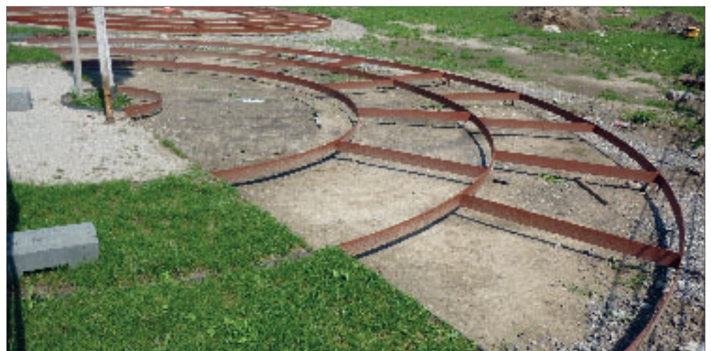
Neue Grabfelder in Kreisform: die Erweiterung der Fläche ist derzeit noch im Bau.
